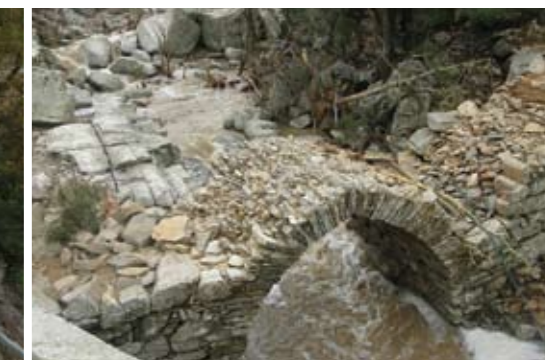
3. Αποδόμηση ανωδομής παλαιού πέτρινου γεφυριού (150 ετών).
